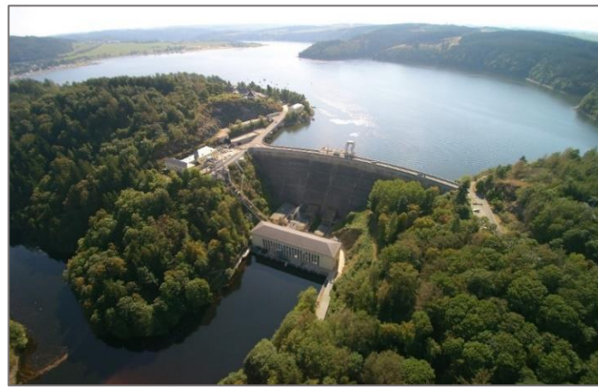
Die Bleilochalsperre, nach Straubels Plänen errichtet.
